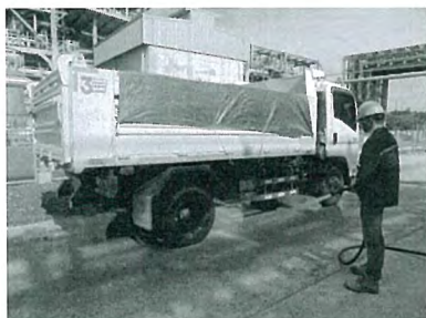
การทำความสะอาดล้อรถบรรทุกที่ออกจากพื้นที่ก่อสร้าง
